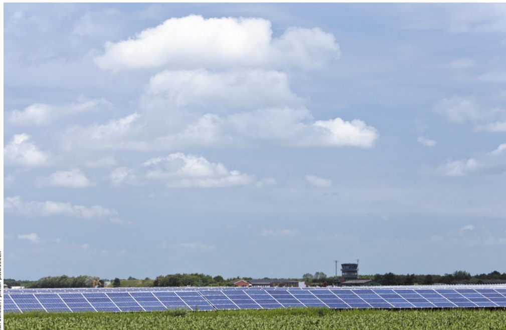
Auch wenn die Sonne scheint, gibt es im hohen Norden meistens Wolken. Die jährliche Globalstrahlung auf horizontaler Fläche beträgt in Eggebek rund 960 Kilowattstunden pro Quadratmeter.
