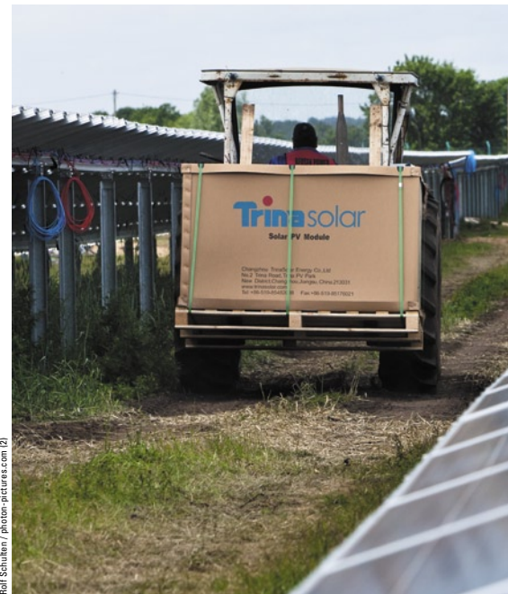
Zeitweise montieren bis zu 300 Arbeiter Module, alle paar Tage gehen neue Fünf-Megawatt-Cluster der Anlage ans Netz
