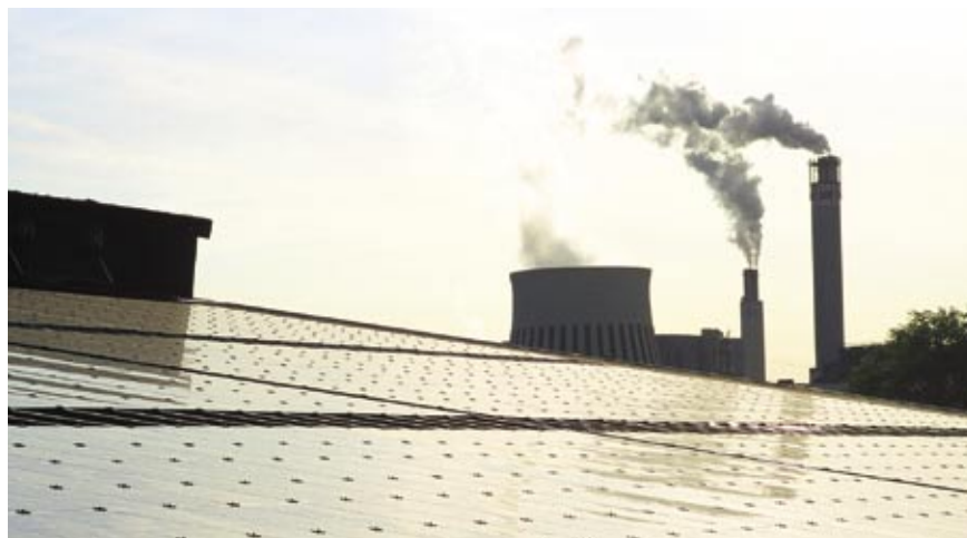
Kontrastprogramm: Eine Solarstromanlage (im Vordergrund) spielt in einem regenerativen Kraftwerkspark eine ganz andere Rolle als Kohle- oder Kernkraftwerke in einem konventionellen. Ein direkter Vergleich zwischen den einzelnen Kraftwerkstypen auf Basis der verfügbaren Leistung hinkt deshalb.
